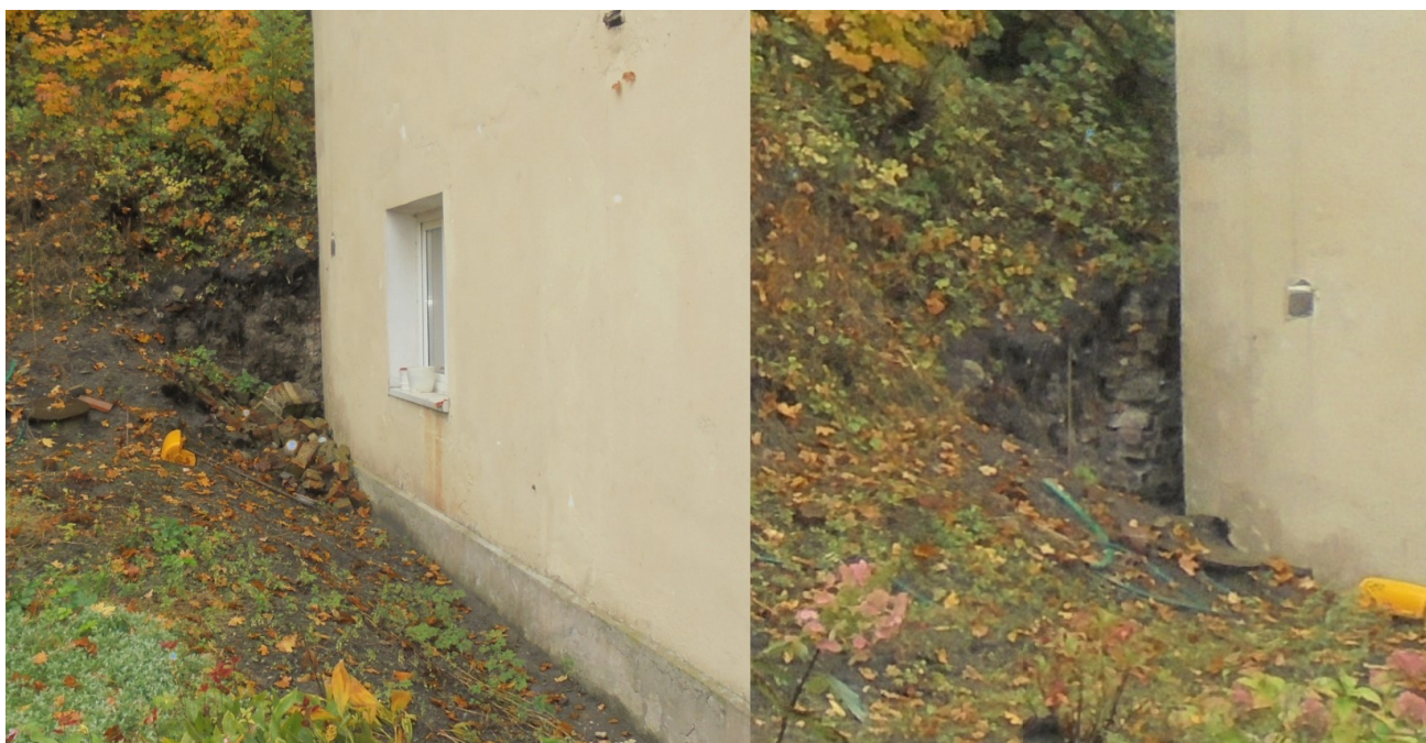
Zdj.1. Widok uszkodzonego murku z cegły na zaprawie
