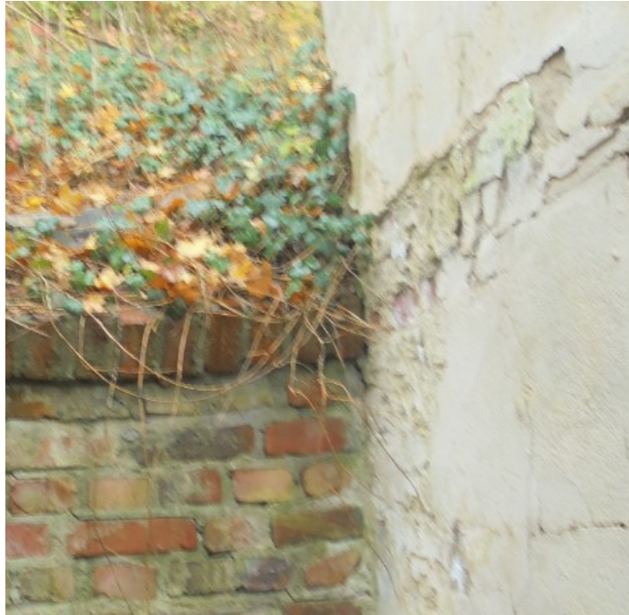
Zdj.1. Widok uszkodzonego muru pomieszczenia gospodarczego (po prawej)
